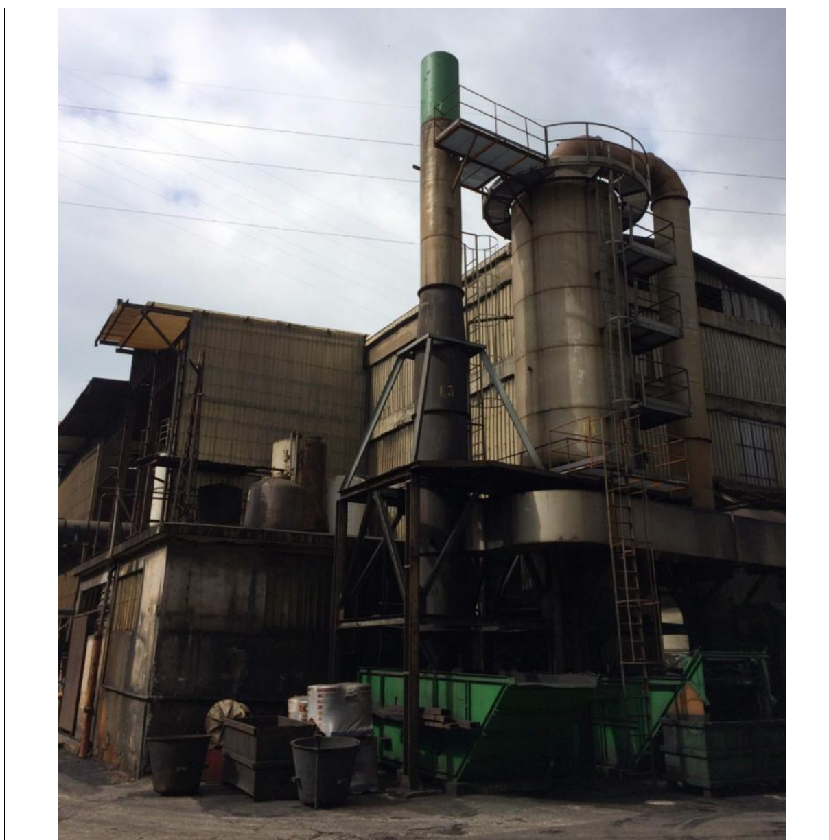
Figura 2.5 – Fonderie Pisano: stralcio fotografico della sorgente emissiva E3 – camino (Data: maggio 2016).
