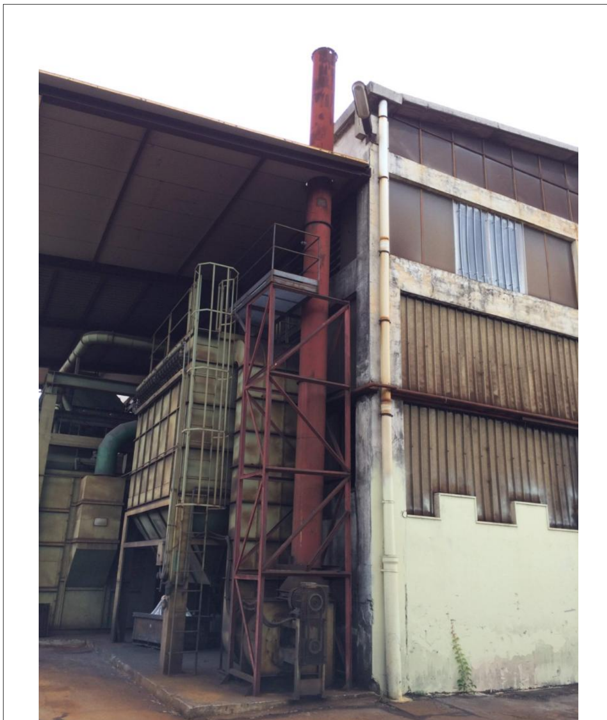
Figura 2.11 – Fonderie Pisano: stralcio fotografico della sorgente emissiva E10 – camino (Data: maggio 2016).
